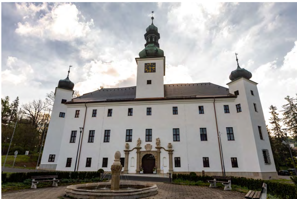
Zrekonstruovaný zámecký hotel Třešť
