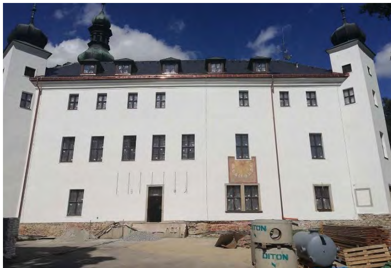
Zámecký hotel Třešť v průběhu rekonstrukce
