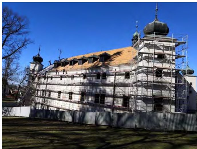
Rekonstrukce zámku v Třešti
