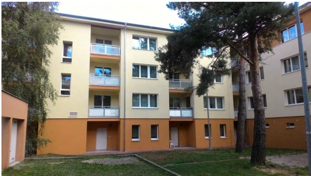
Zateplení objektu Rozvojová
