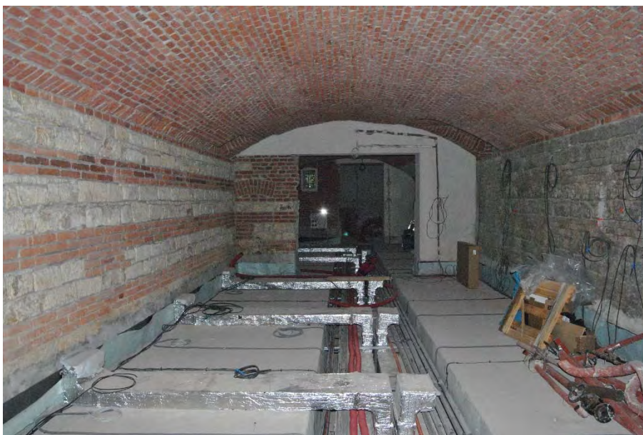
Oprava jednacího sálu VL
