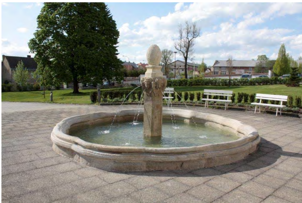
Opravená kašna v Třešti
