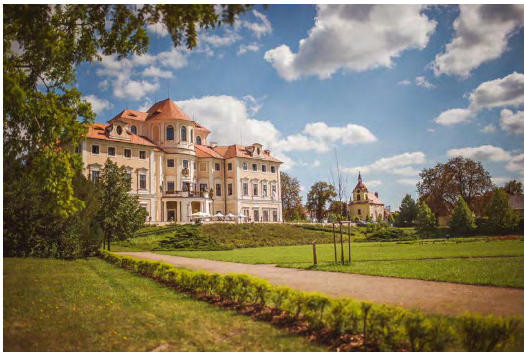
Opravené cesty v zámeckém parku
