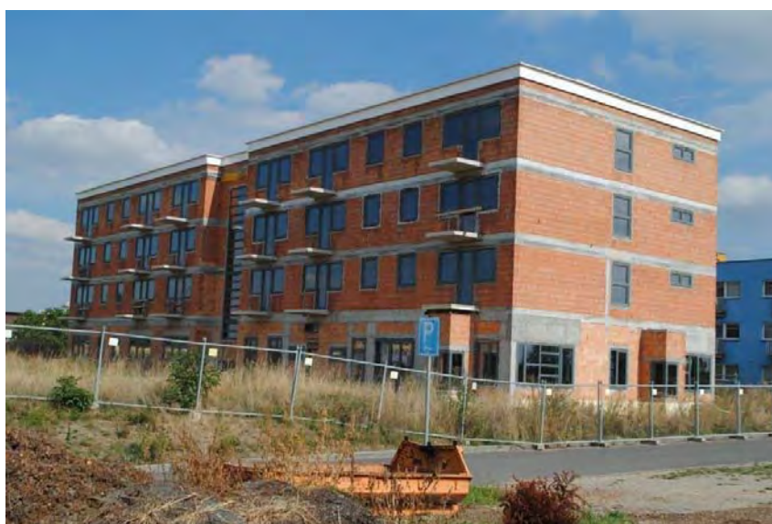
Rozestavěná ubytovna v Krči
