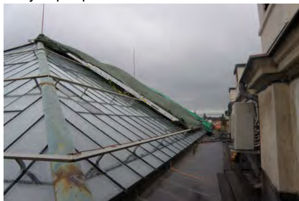
Oprava světlíku po výbuchu plynu
