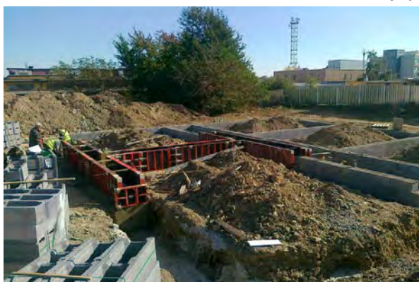
Stavba ubytovny U2 v Krči – začátek
