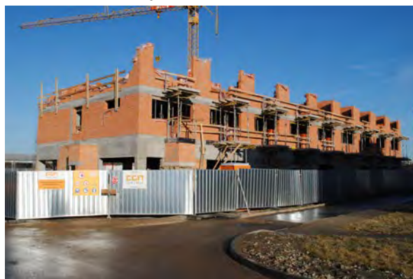
Stavba ubytovny U2 v Krči – průběh
